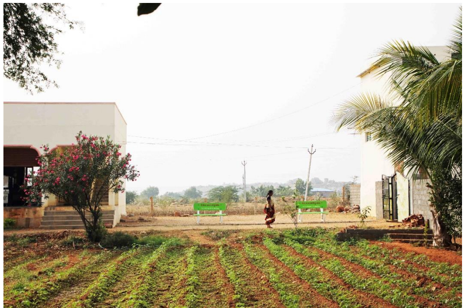
Hier entsteht der neue Speisesaal
